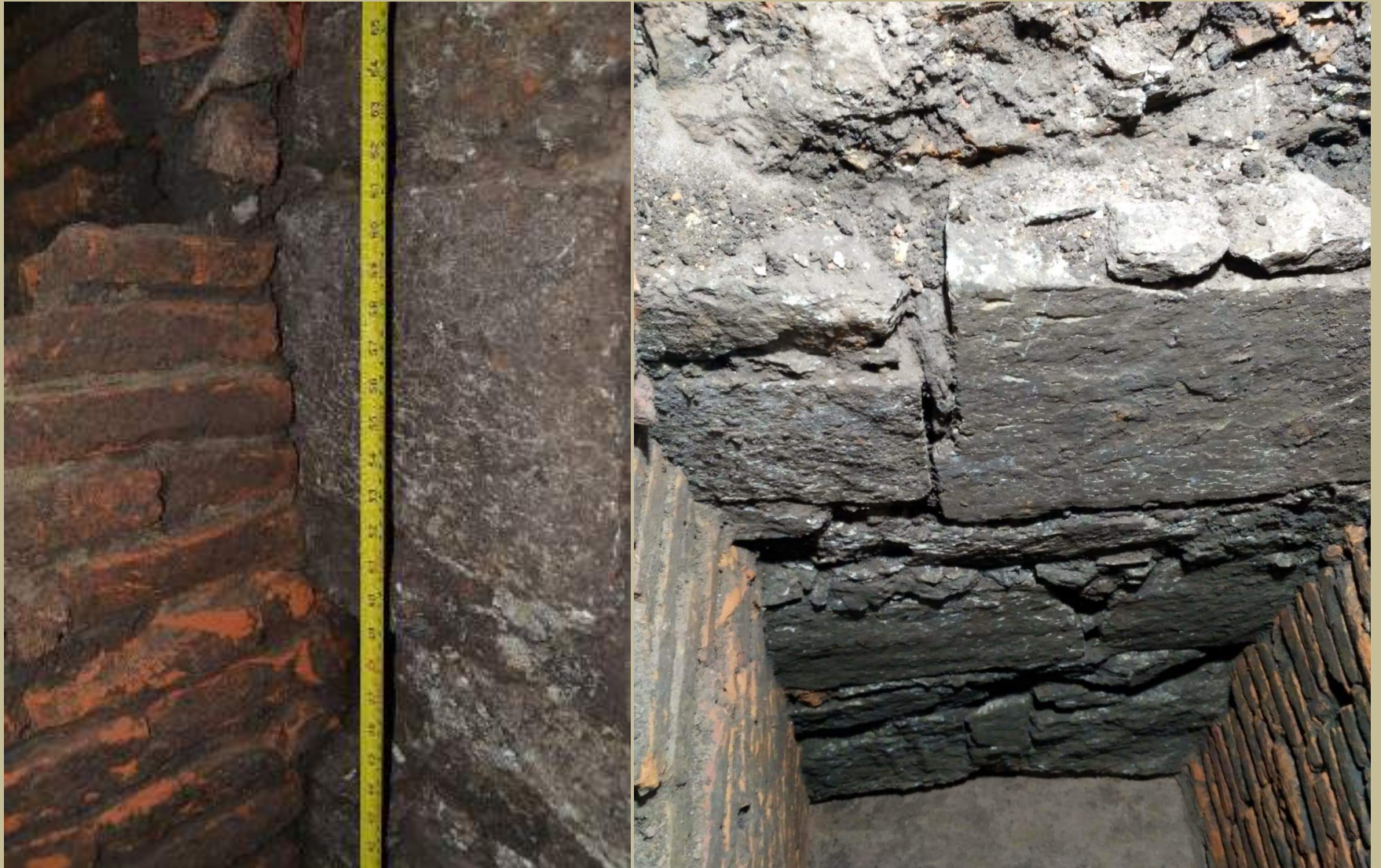
Detalle del contacto entre el paramento de ladrillos que adosa/apoya al muro de piedra.
