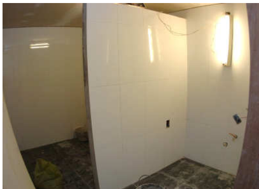
Obra de baños para discapacitados
