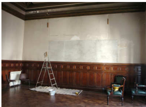
Obras en Sala Lavalleja
