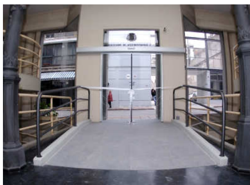
Acceso principal con rampa para discapacitados
